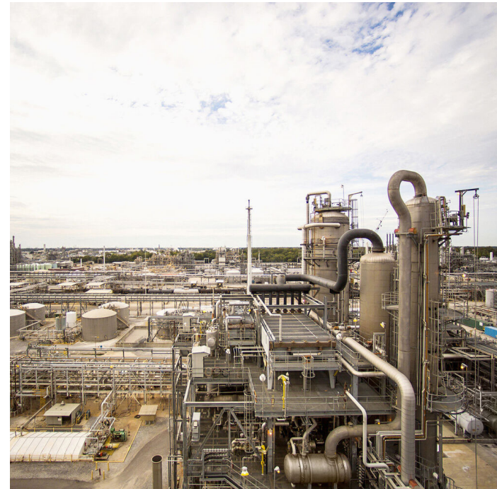
BASF-Anlage in Geismar, Louisiana, USA
